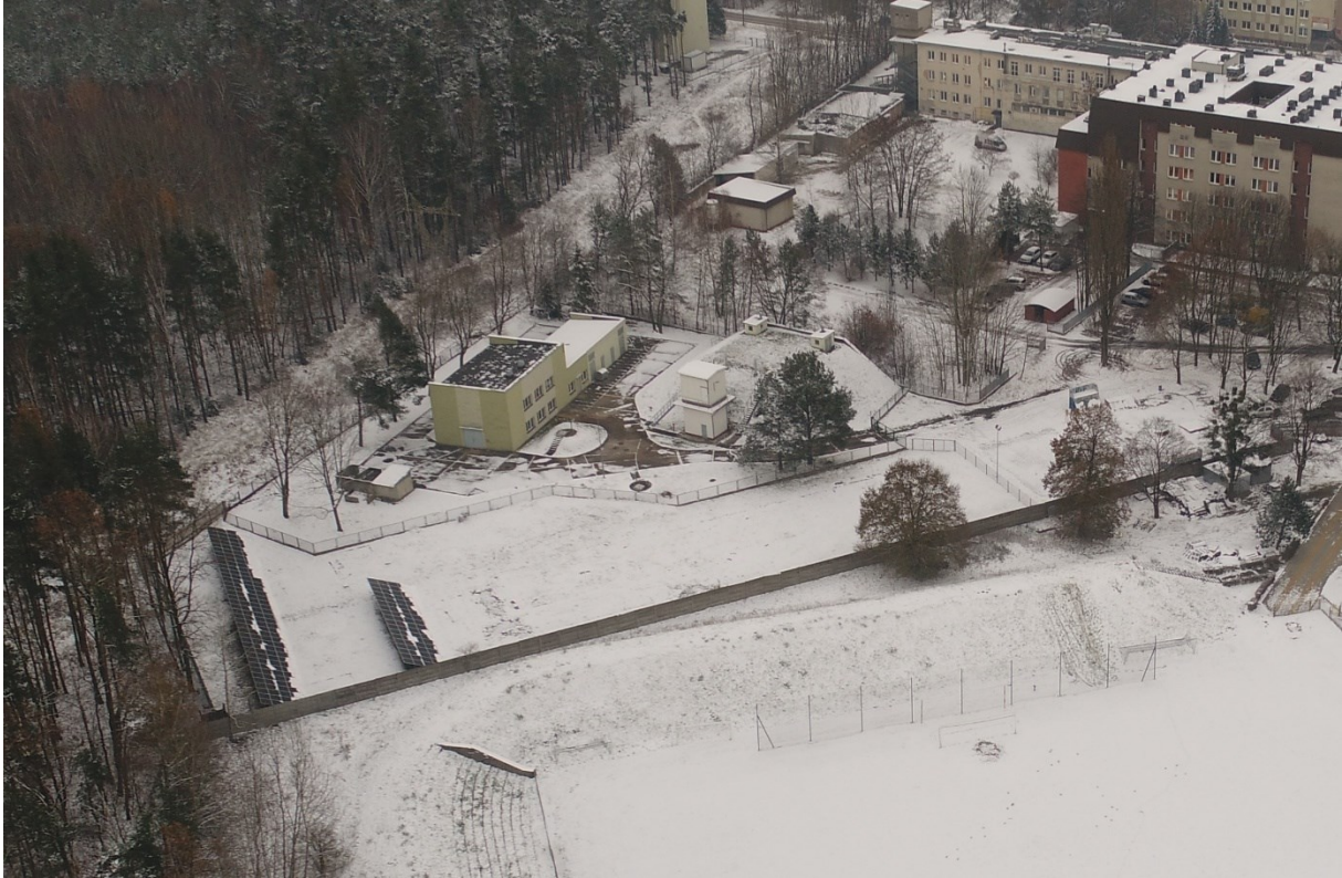
Ryc. 6 Stacja uzdatniania wody w sąsiedztwie obszaru opracowania projektu planu Źródło: Fotografia wykonana przez autora prognozy, grudzień 2023 r.
